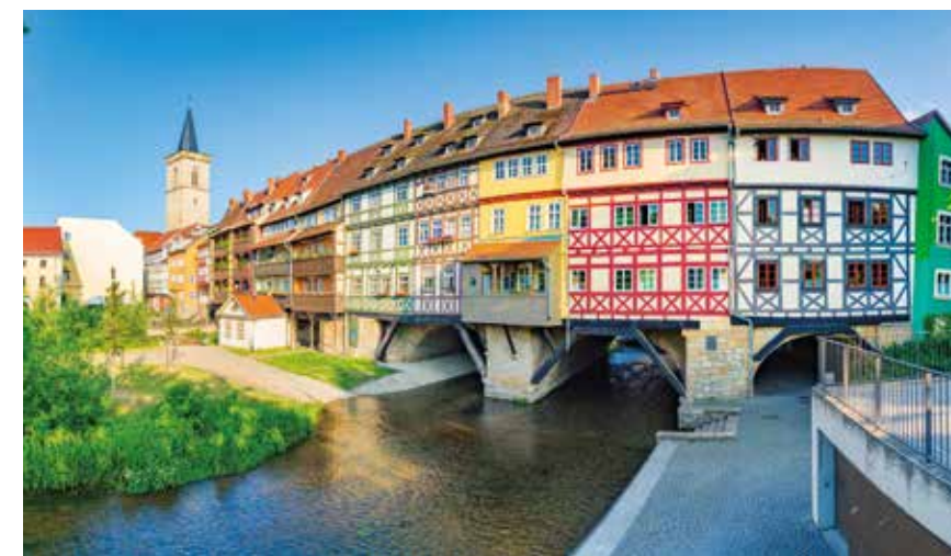
Ponte dos Mercadores (Kramerbrücke) · Erfurt
